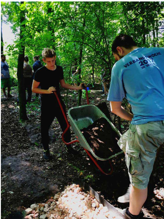
Foto: BdsJ'ler beim Bau des Barfußpfades
